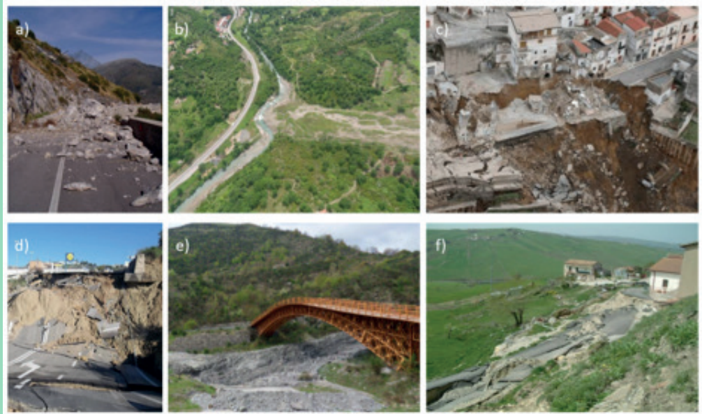
▲ Figura 2: Alcuni esempi di diverse tipologie di frane verificatesi sul territorio regionale: a) crollo (Maratea), b) colata (Trecchina), c-d-f) movimenti complessi (Pomarico, Montescaglioso, Potenza), e) debris flow (Terranova di Pollino).
